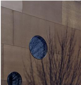
**Fassade** | Entgegen aller ihr innewohnenden Rationalität und Wirtschaftlichkeit zeigt sich die Lagerhalle nach aussen hin verspielt. Die mit einem einfachen Gummiklemmprofil aus dem Fahrzeugbau bündig in die Fassade gesetzten runden Fenster lassen leicht die Assoziation von schwebenden Seifenblasen zu.
